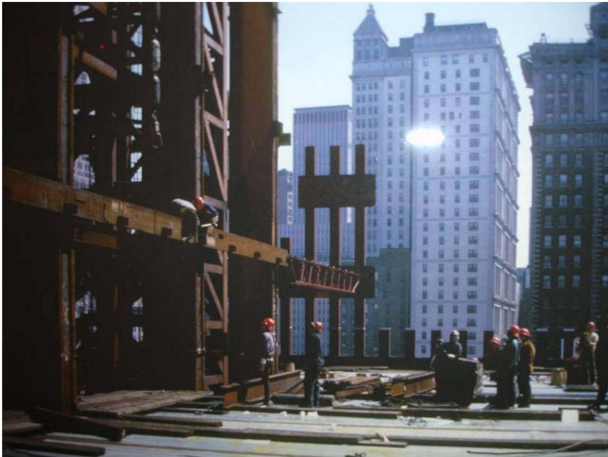
Les armatures d'acier : Le très gros noyau (gauche) est un énorme radiateur. Notez les ouvriers qui se tiennent sur le plancher de l'étage qui est fermement attaché aux colonnes reliées ensemble au noyau.
