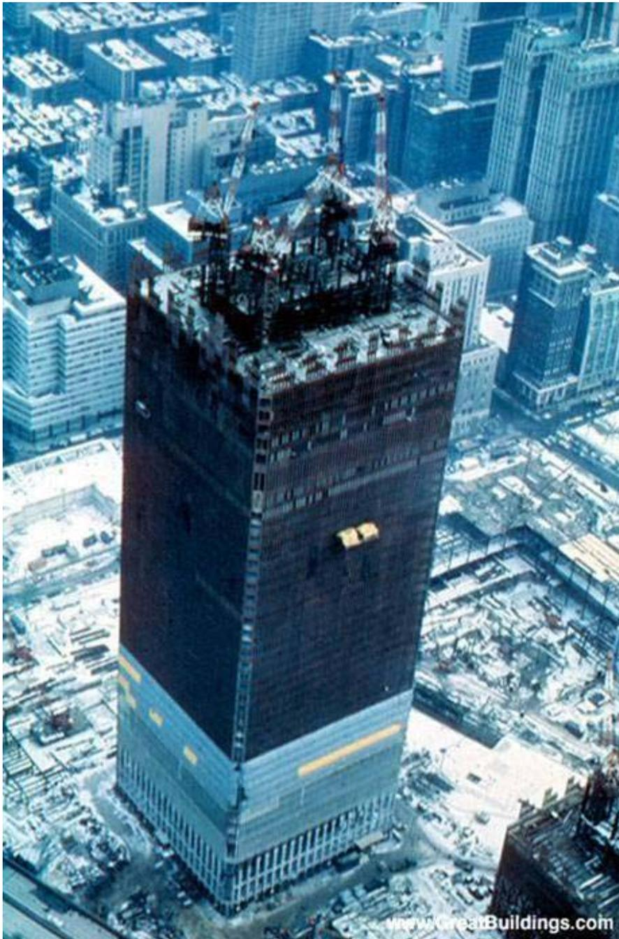
Les tours du WTC ont été solidement construites avec 47 colonnes en acier dans le noyau et 240 colonnes d'acier en périmètre. Pour un total de 287 colonnes d'acier. Beaucoup doutent que le feu et les dommages aléatoires pourraient les faire s'effondrer verticalement (théorie officielle) et suspectent l'utilisation d'explosifs.
