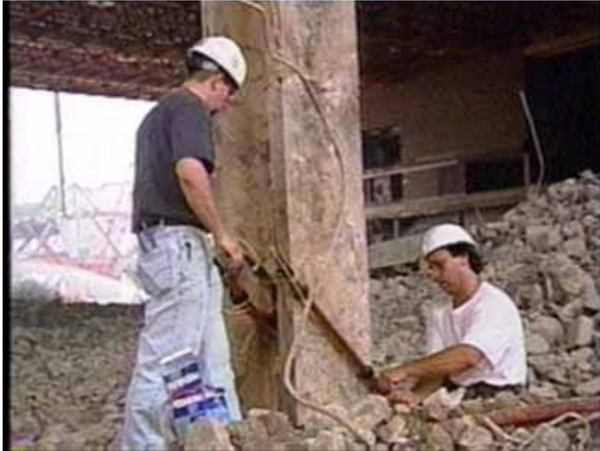
Ci-dessus: deux hommes installent un coupeur de charge conventionnelle sur une poutrelle en acier, se préparant à une démolition commandée du bâtiment. Notez la largeur étroite de la charge explosive du coupeur. Provenance 'History Channel' : "Wrecking ball-Modern marvels" et remerciements à Robert Moore et <http://piratenews.org/911con.html>.
